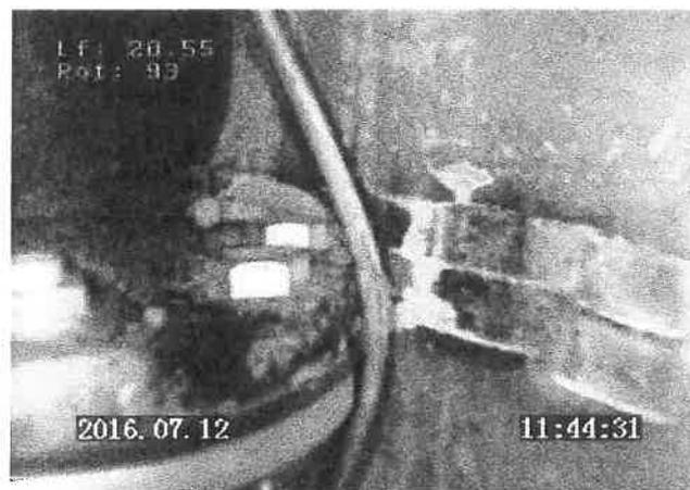
**Aspirations des pompes à 21,5m. Pompes en contact l'une contre l'autre.**
